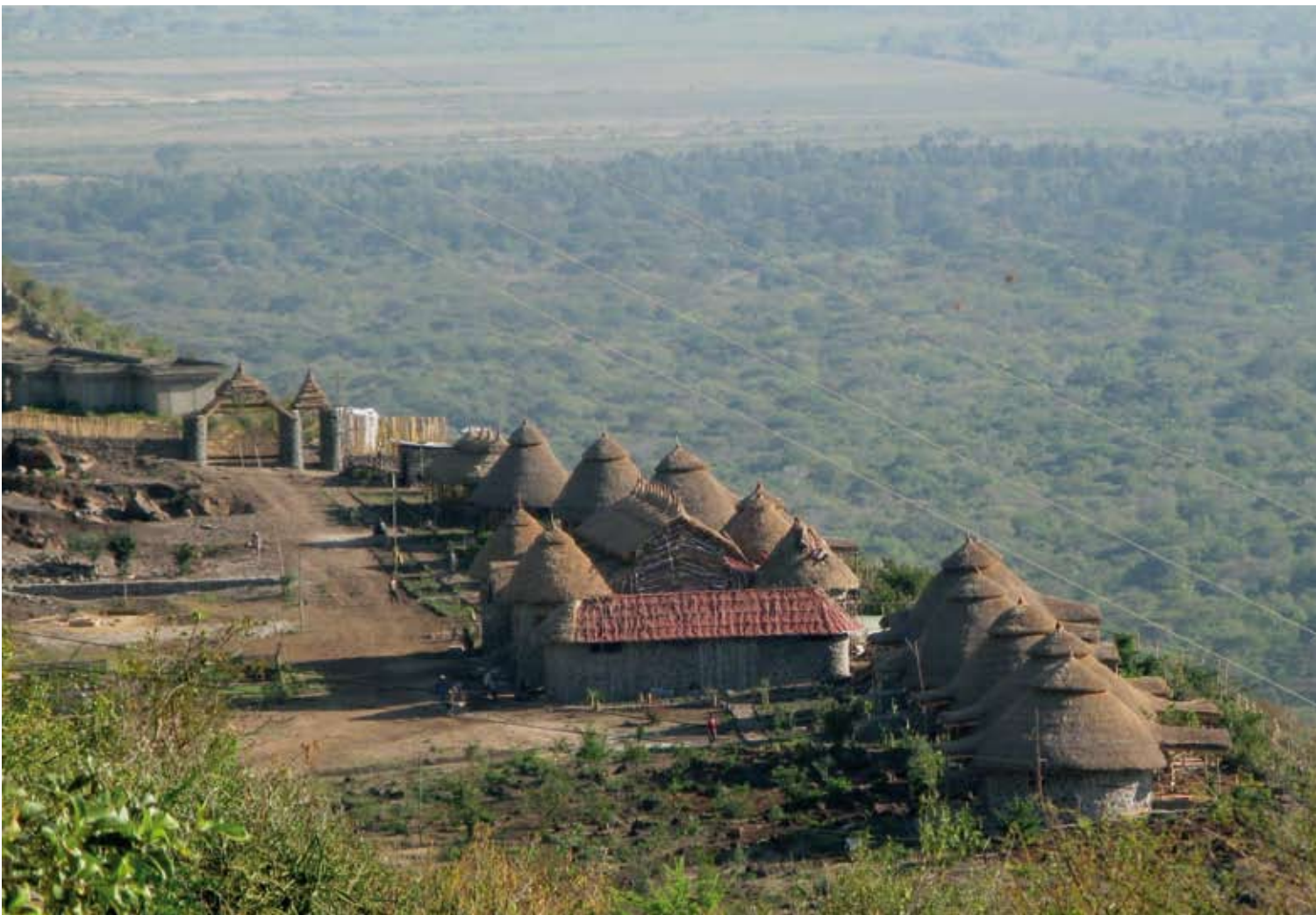
Hotel in aanbouw met uitzicht over het Nech Sar National Park.
